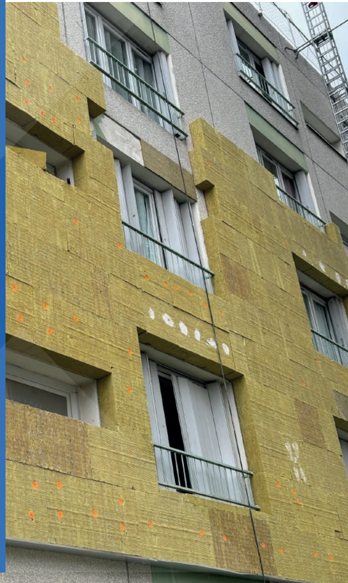
Épaisseurs de 60 à 240 mm Dimensions 1200 X 600 mm
