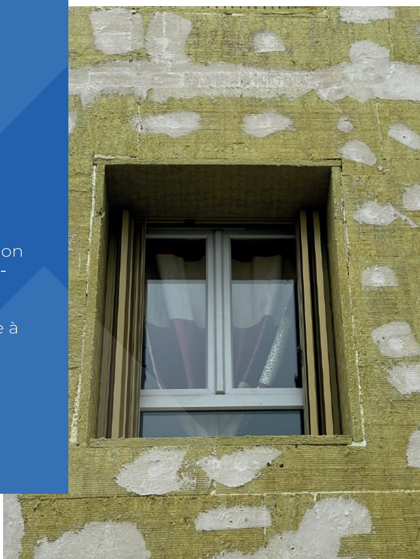
Épaisseurs de 30 à 60 mm Dimensions 1200 X 1000 mm
