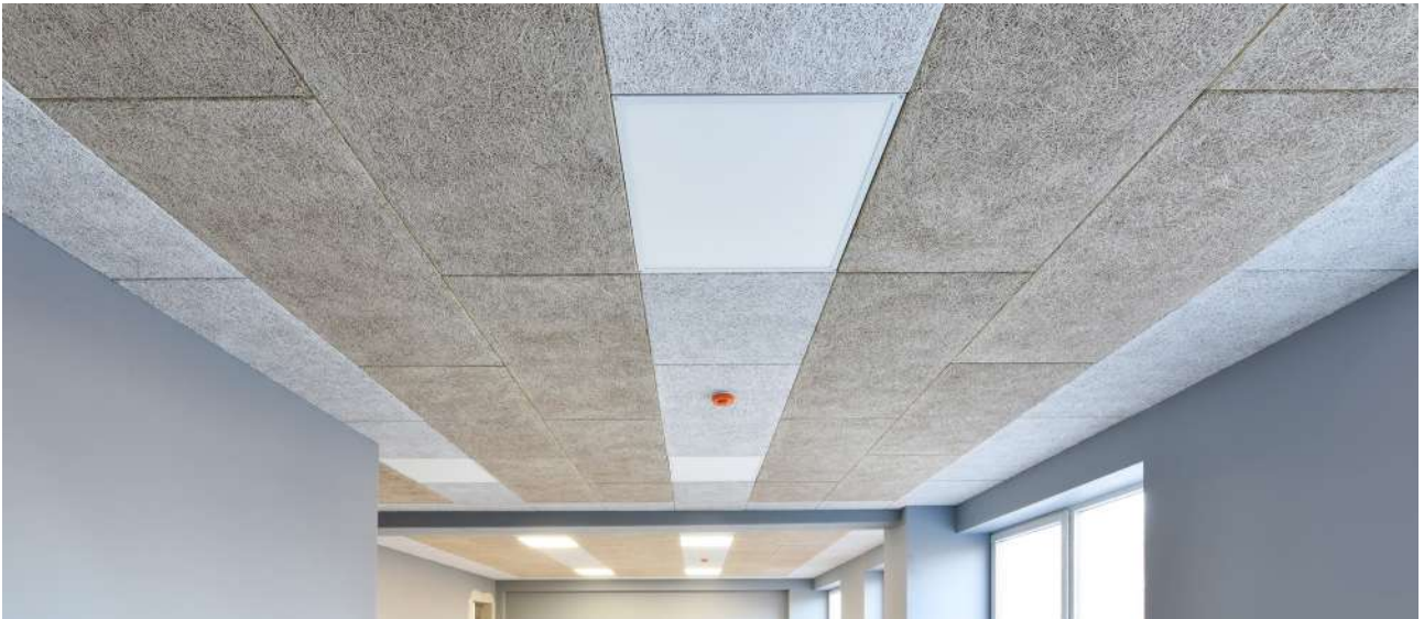
Structure en profilé CD en métal, profilé de bord P5, panneau acoustique KARDIGAN by Cewood 25 mm
