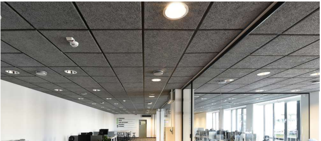
Structure profilé de type T, profilé de bord P0G, panneau acoustique KARDIGAN by Cewood de 25 mm
