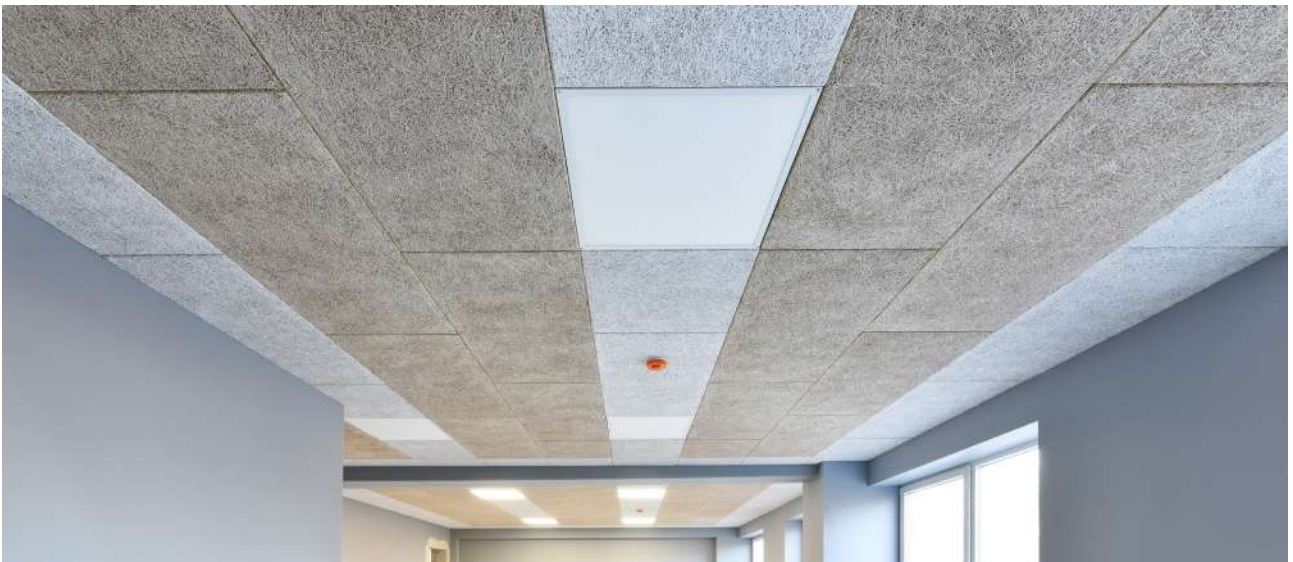
Structure profilé de type T, profilé de bord P0G, panneau acoustique KARDIGAN by Cewood de 25 mm
