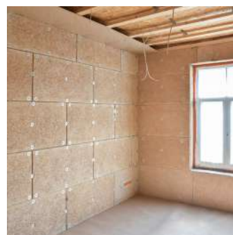
Panneaux de construction
